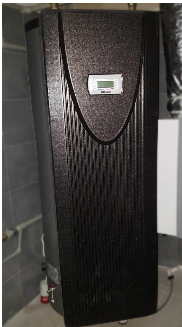
Pompa ciepła zamontowana przez firmę Supraterm w budynku pasywnym w Jaworznie.
