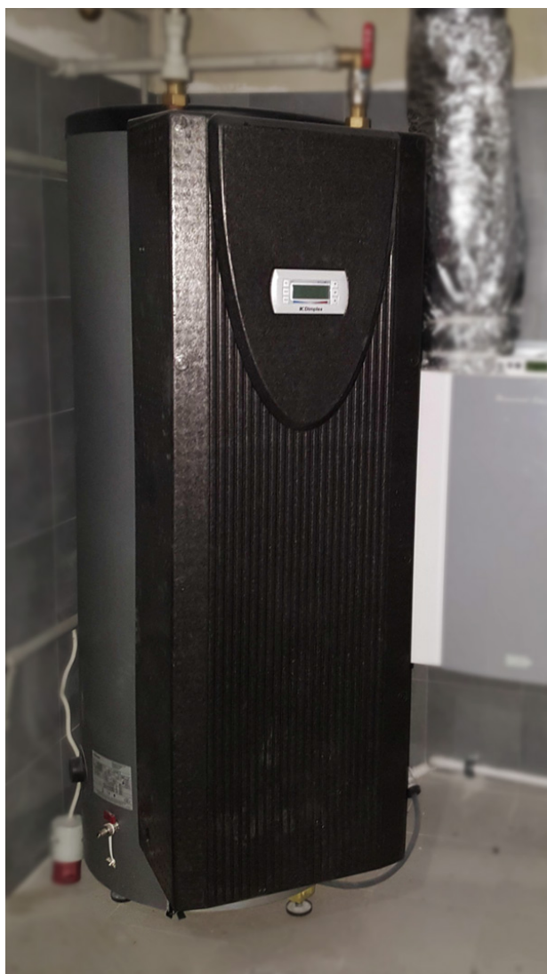
Pompa ciepła zamontowana przez firmę Supraterm w budynku pasywnym w Jaworznie.
